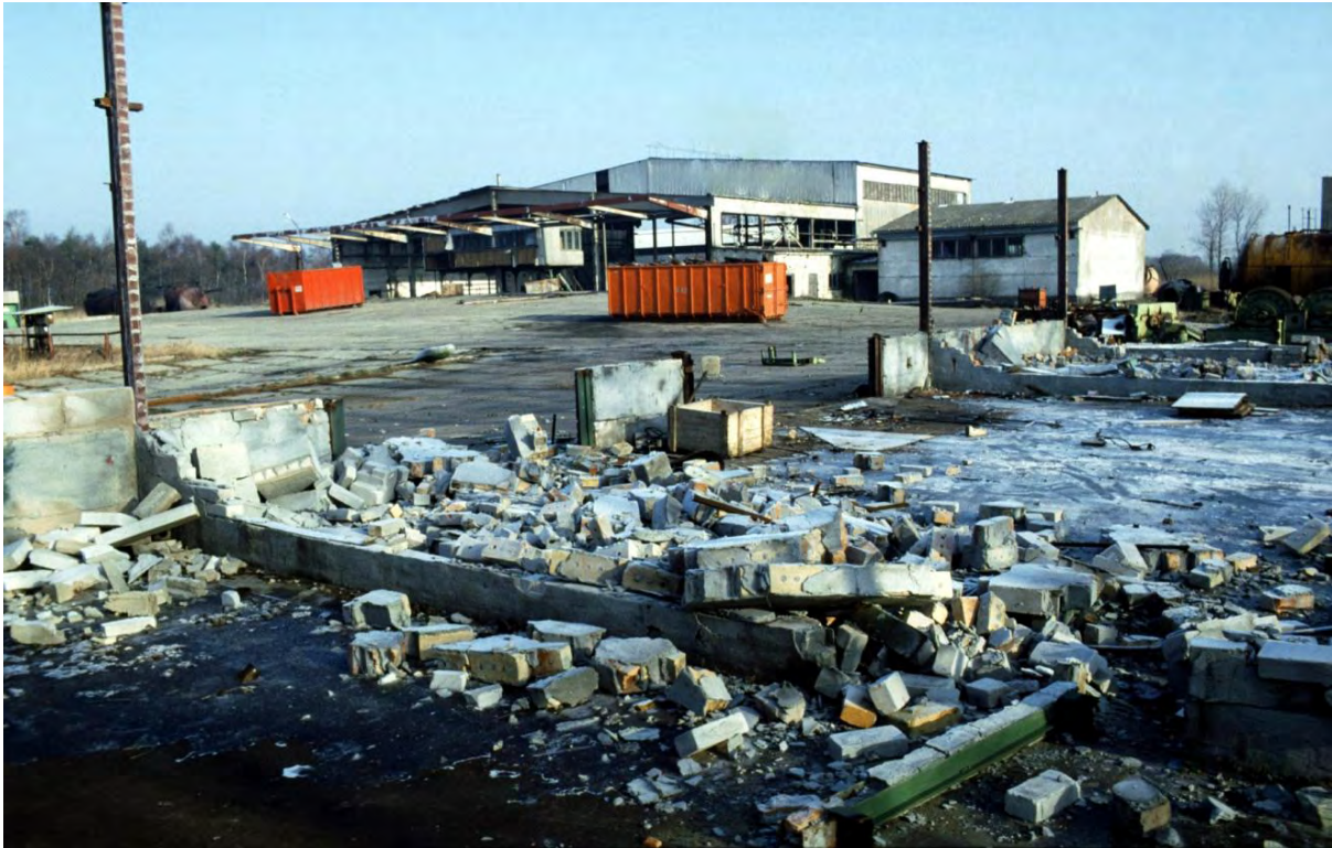
Abriss des Trockenwerkes in der Sundischen Wiese, Foto: H. Sporns, April 1993
